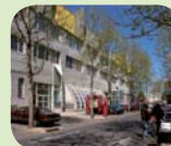
Campus de la Plaine Saint Denis Halle Montjoie 5, rue de la Croix-faron 93200 Saint Denis tél. 01 55 93 75 00
